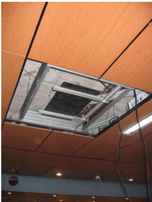
Soporte CMRD-L50 en fase de montaje
